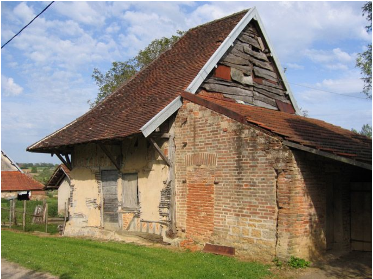
Vue d'ensemble de la façade.
