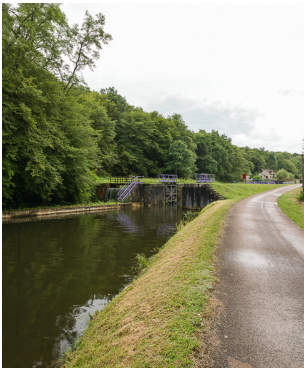
Vue du déversoir de superficie.
