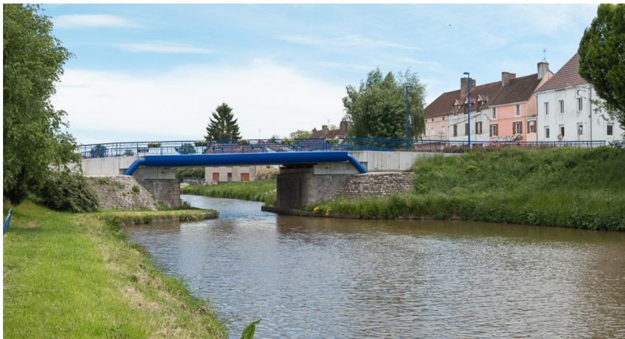
Le pont, vu d'aval.
