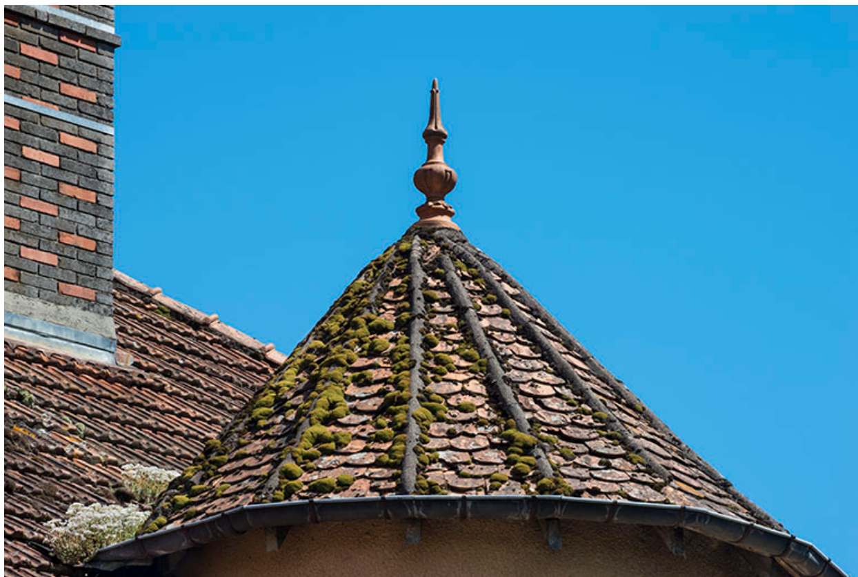
Toit conique nervuré de la tour demi-hors-œuvre.
