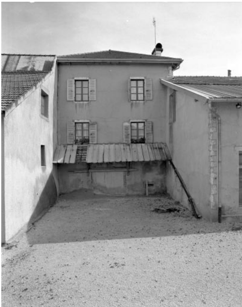
Façade postérieure du corps latéral.
