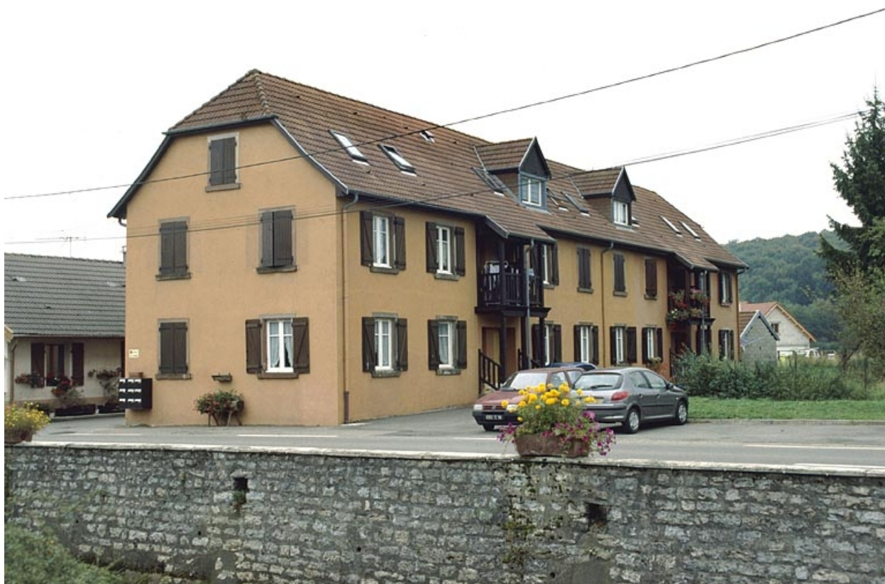
Logement ouvrier collectif.
