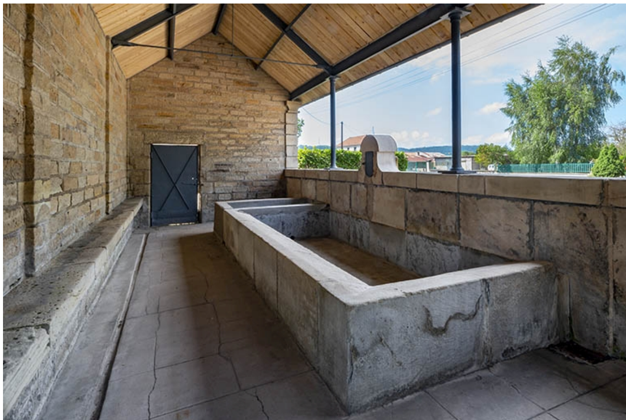
L'intérieur du lavoir, depuis le côté gauche.
