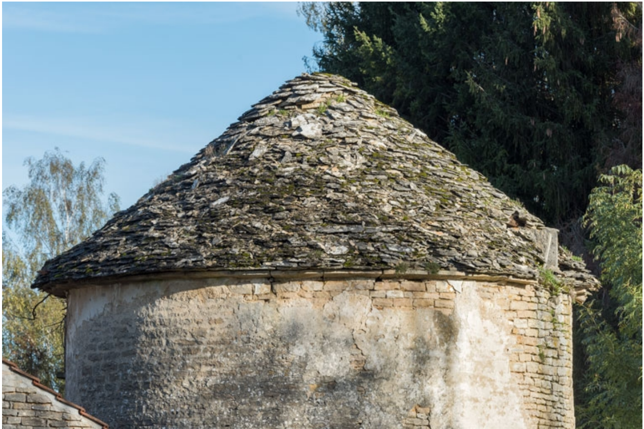
Détail de la toiture depuis le sud.
