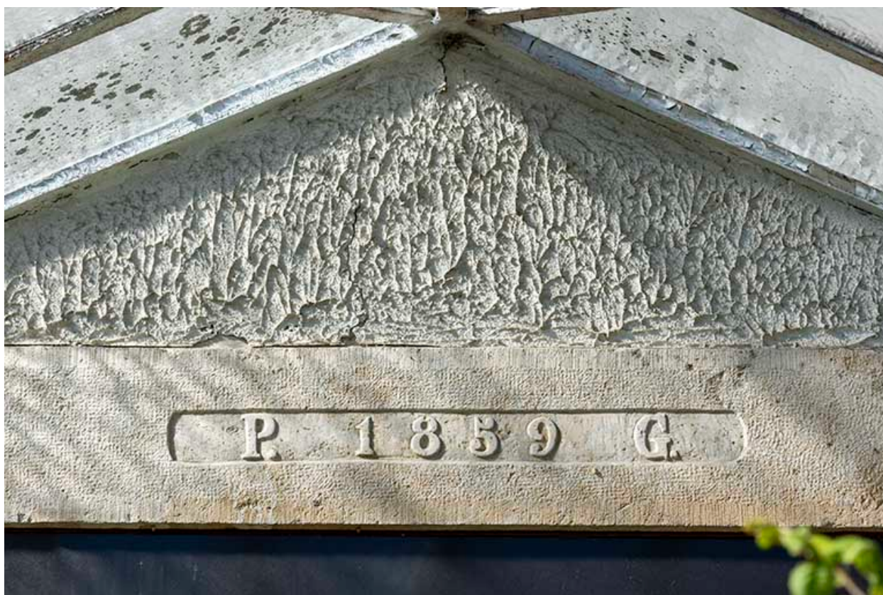
Maison au n° 45 : linteau daté.
