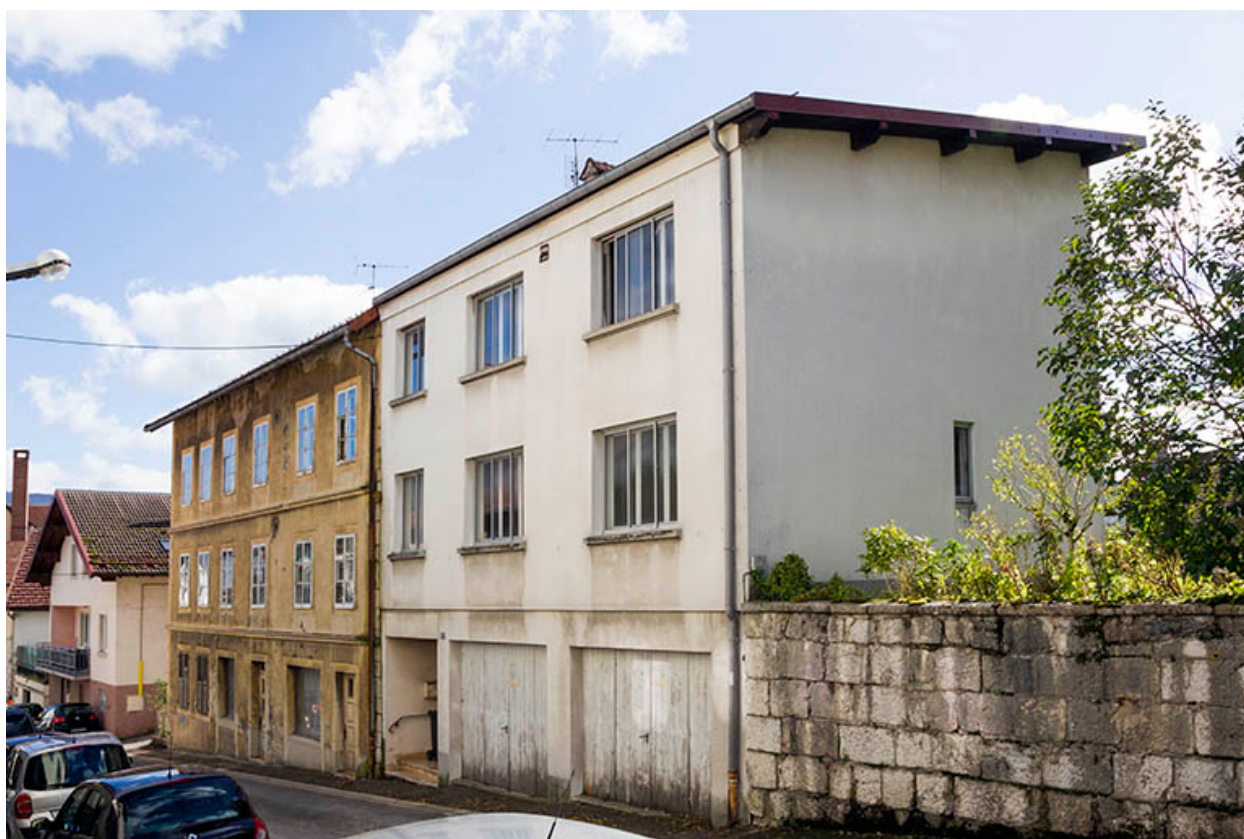
Façades antérieure et latérale droite.
