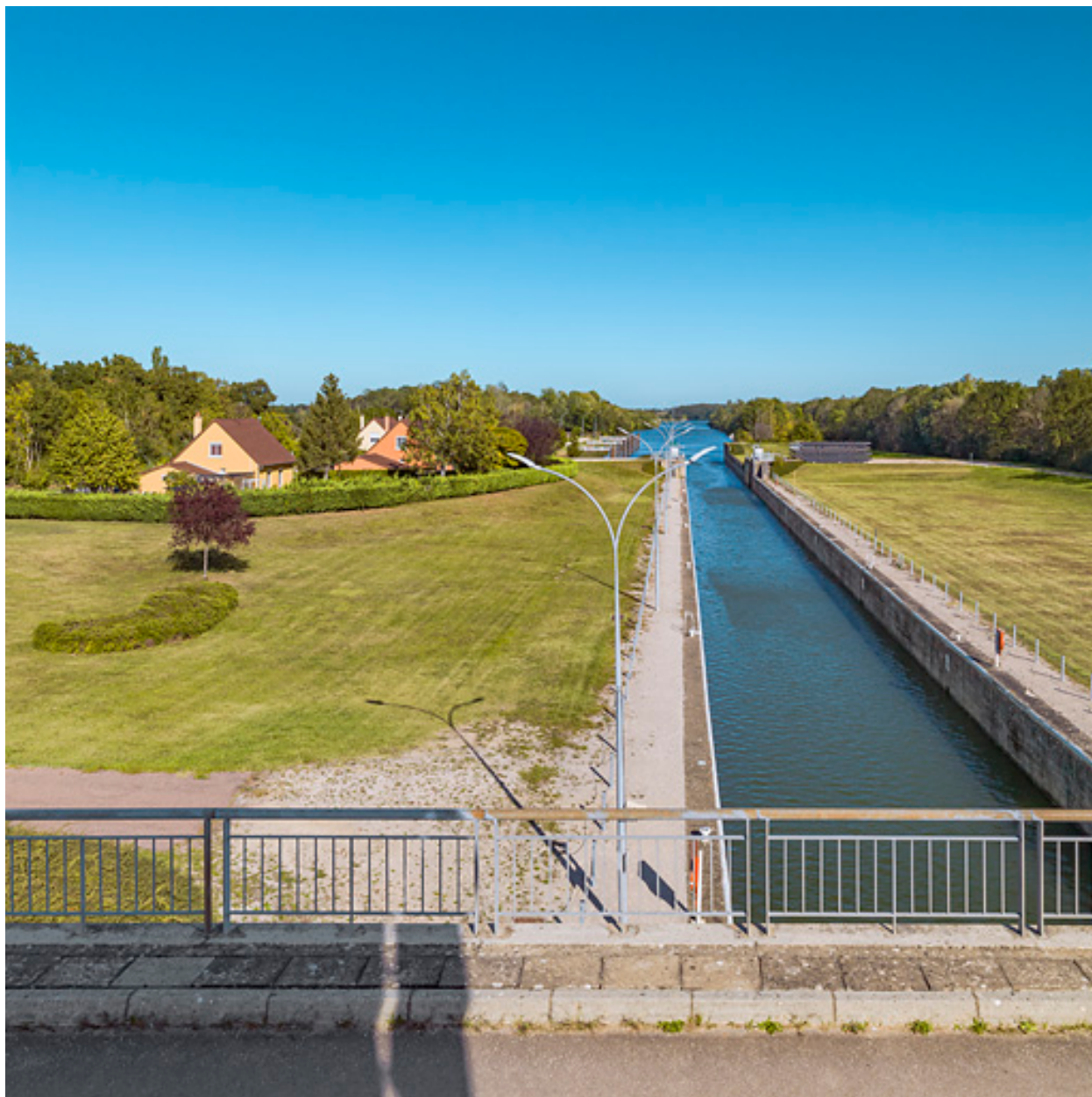
Le site d'écluse à grand gabarit d'Ecuelles (71).
