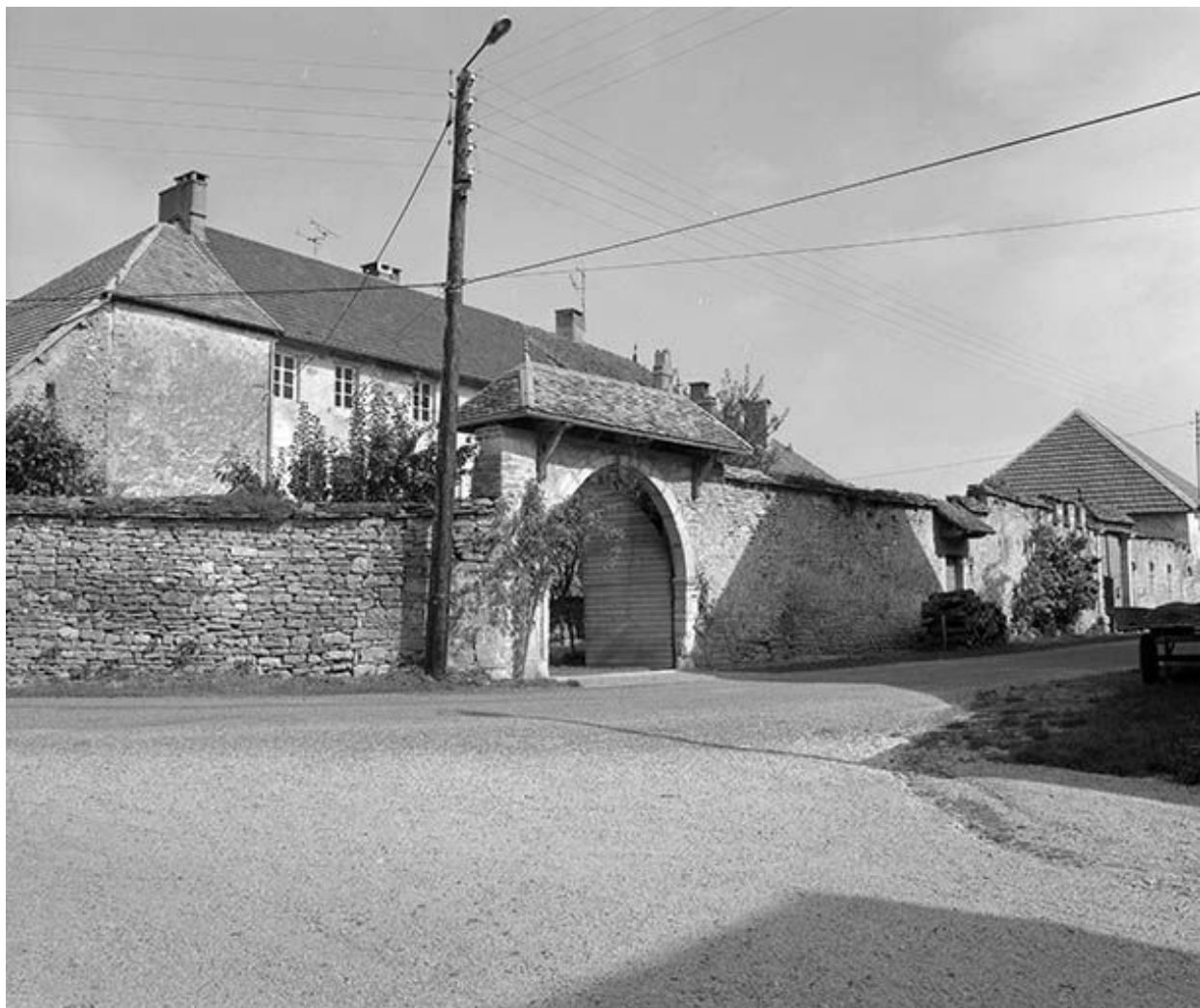
Demeure située rue de l'Eglise.
