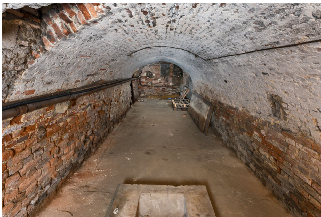
Cave voûtée au sous-sol.
