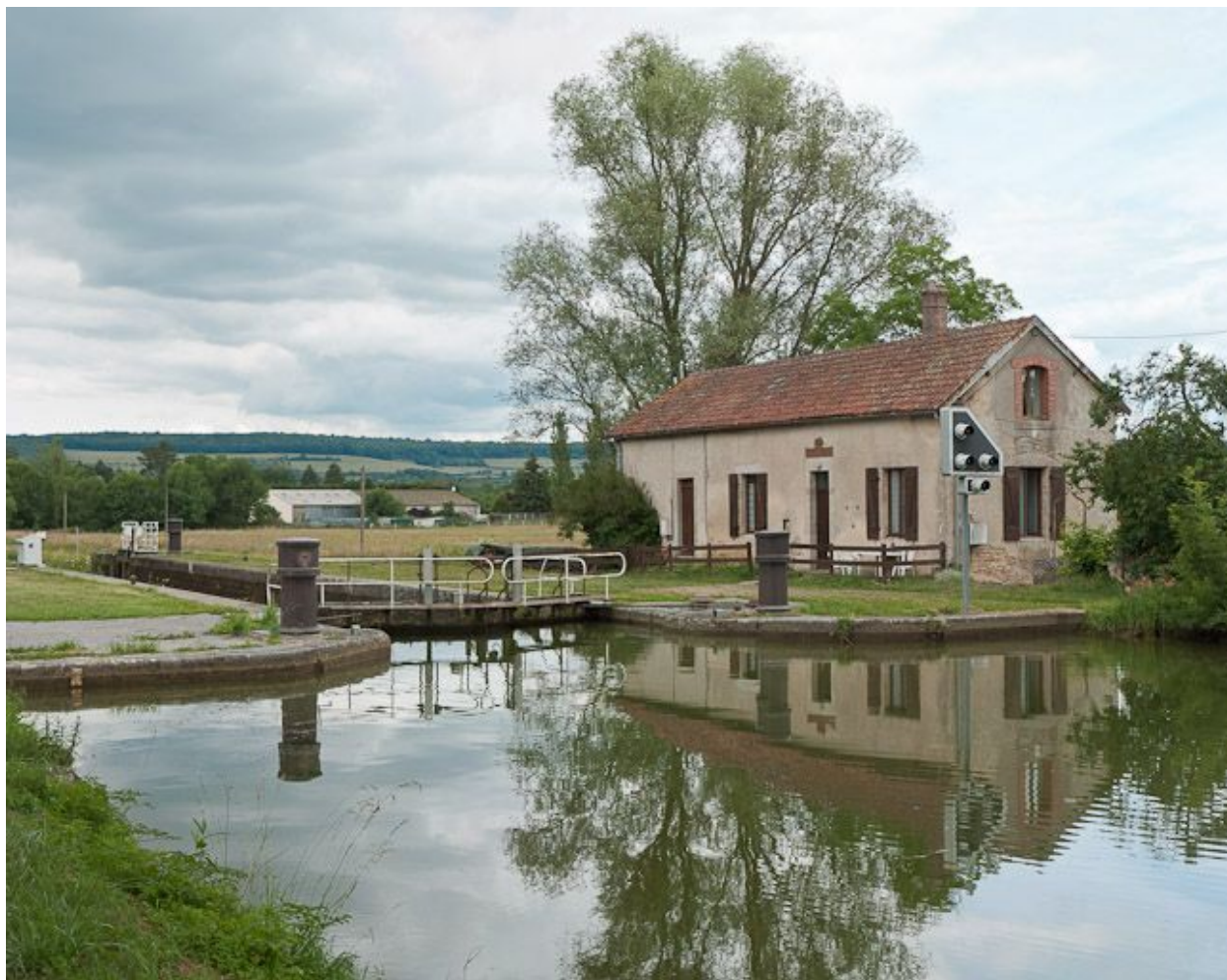
Vue d'ensemble du site d'écluse.
