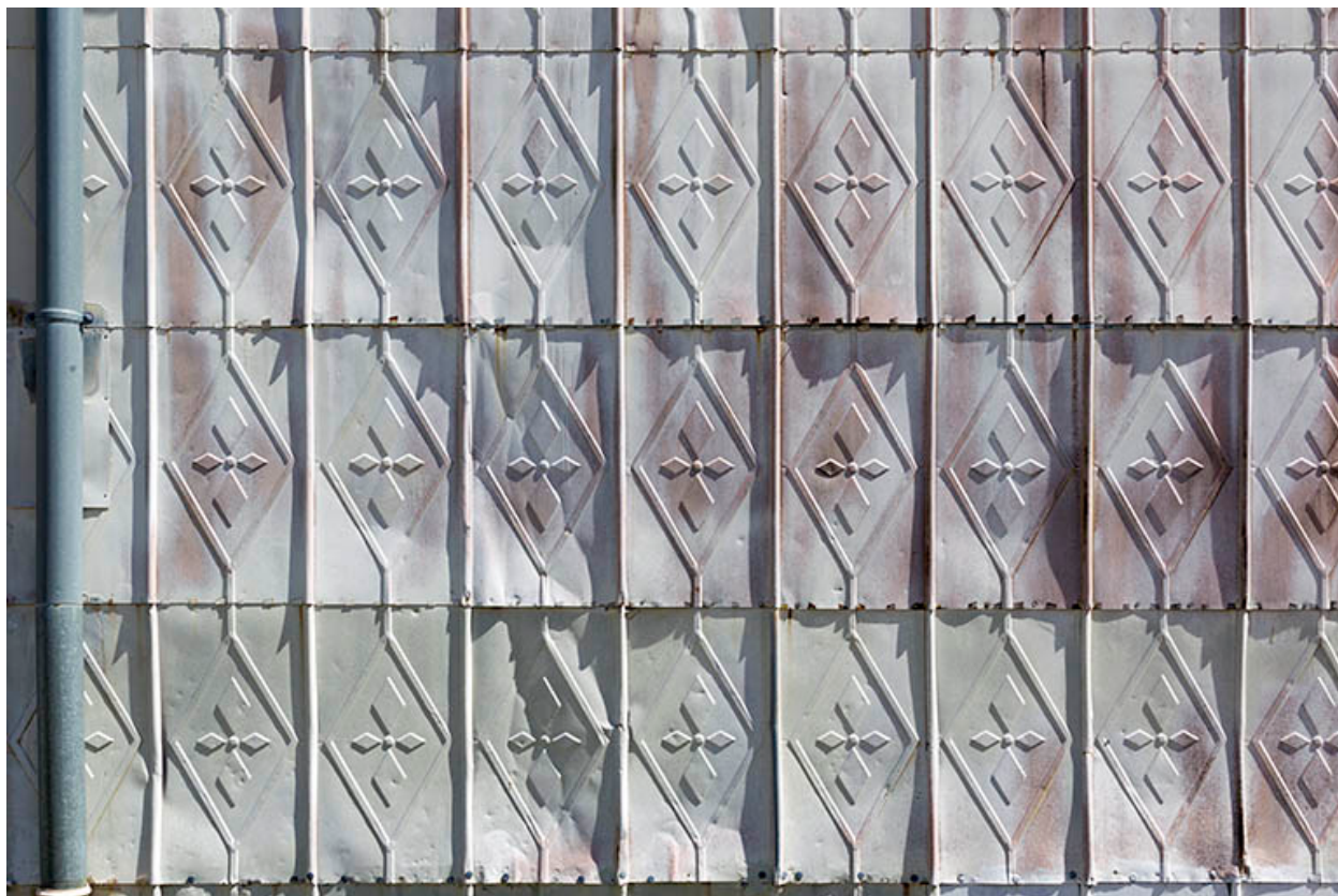
Façade latérale droite : essentage de tôle.
