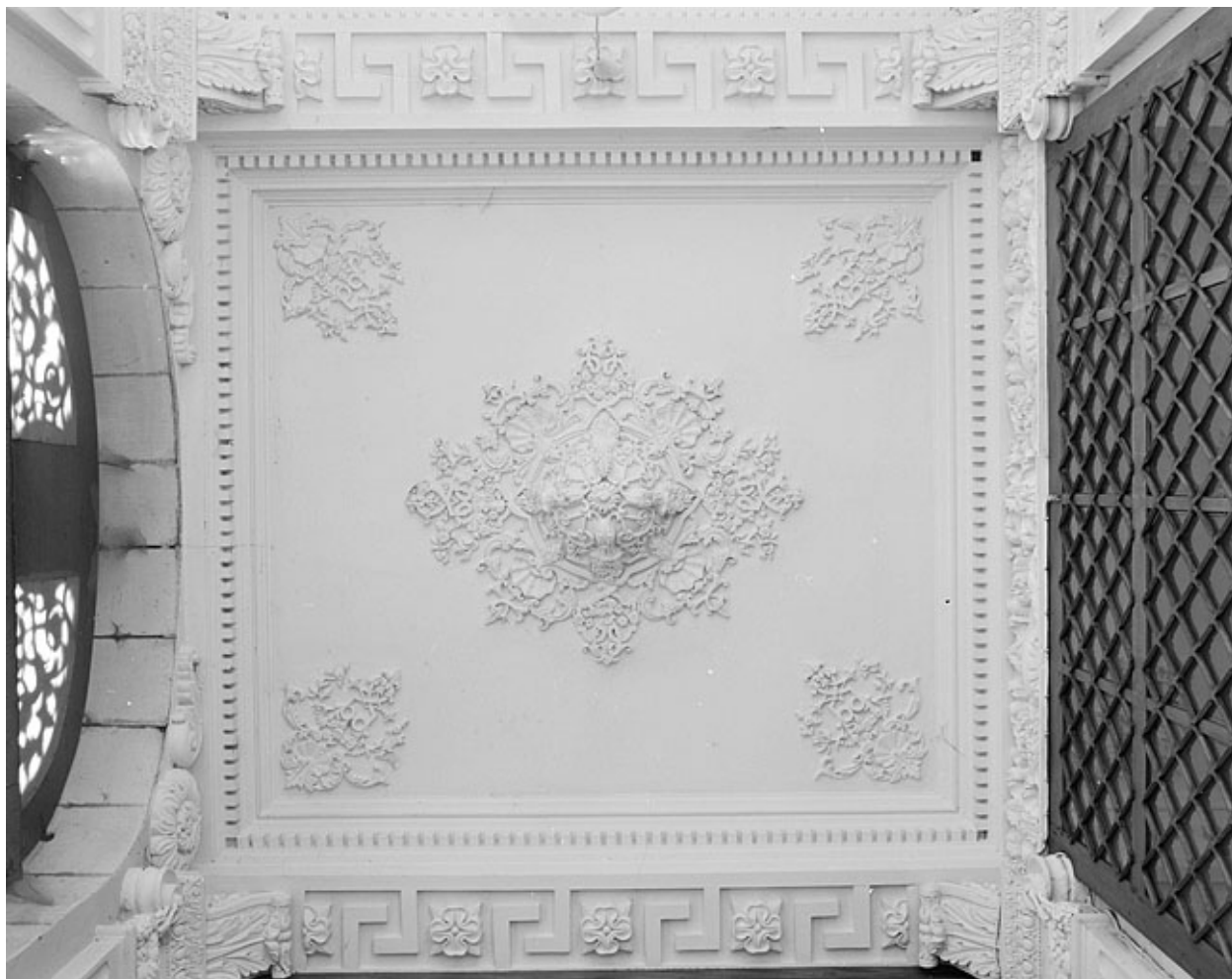
Vestibule, détail du plafond.
