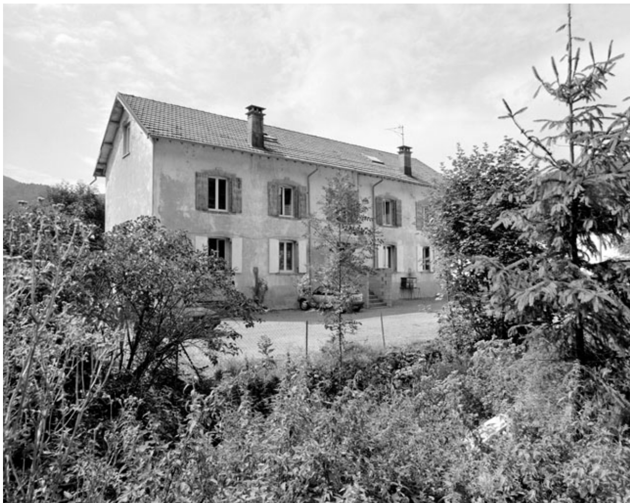
Façade antérieure du logement d'ouvriers.
