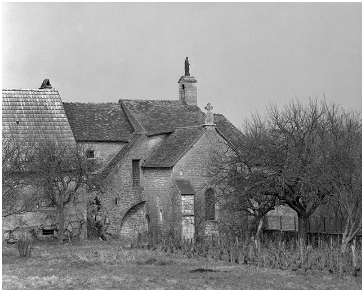
Façade latérale droite.
