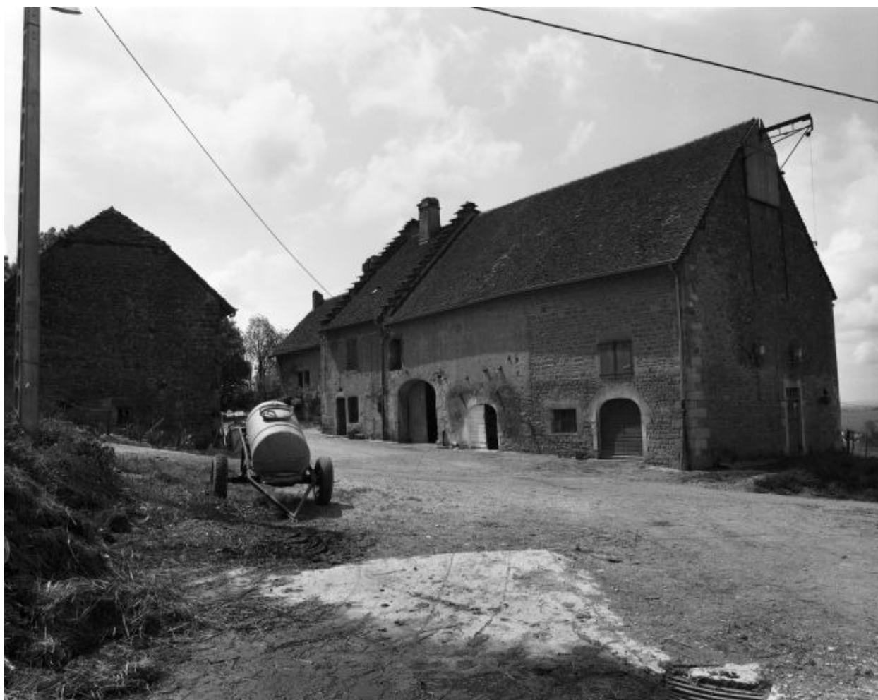
Ferme située chemin du Château.
