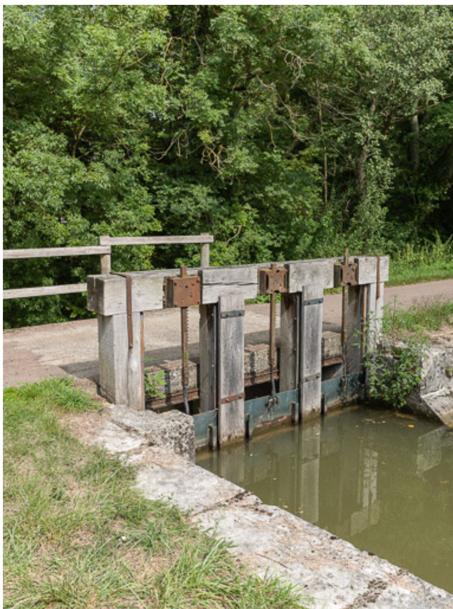
Le déversoir de fond, côté canal.
