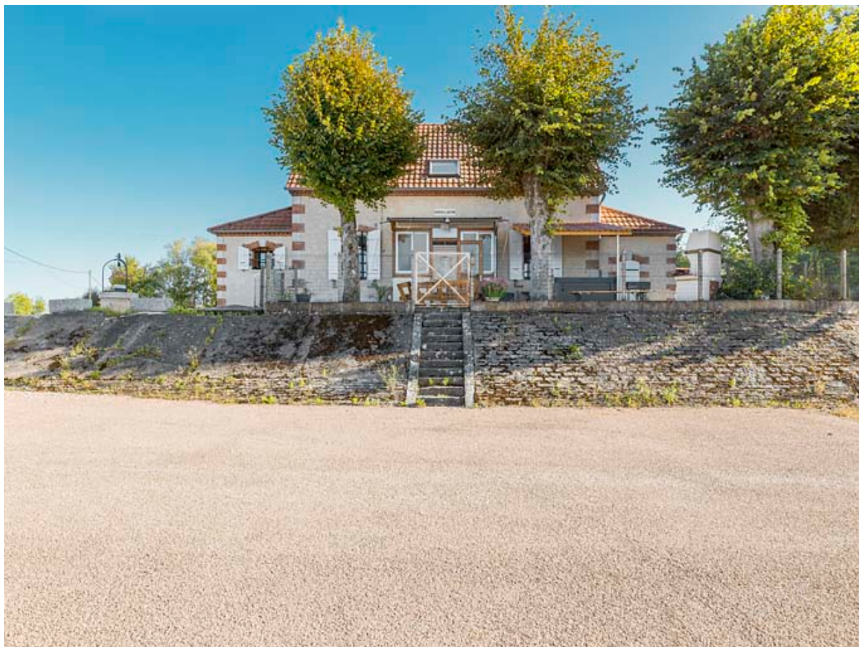
Vue d'ensemble de la maison du barragiste.
