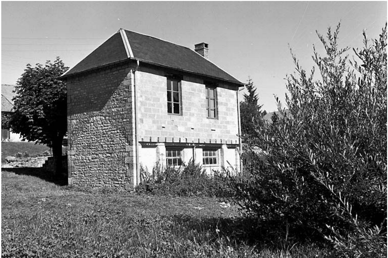
Façade postérieure et face latérale droite.
