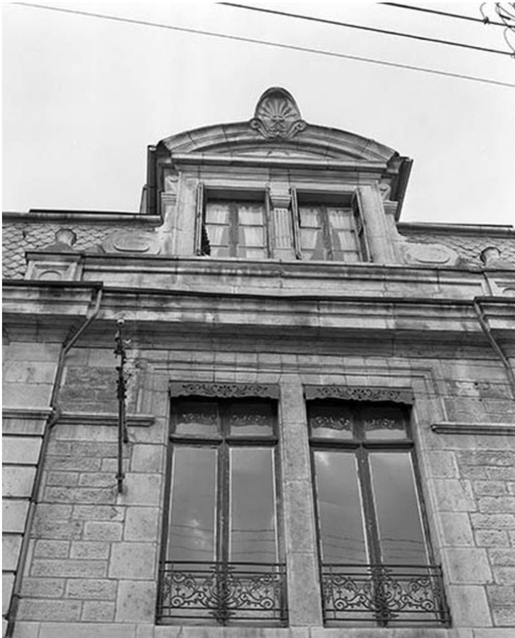
Façade antérieure de l'atelier sur rue. Détail de la travée centrale (1977).
