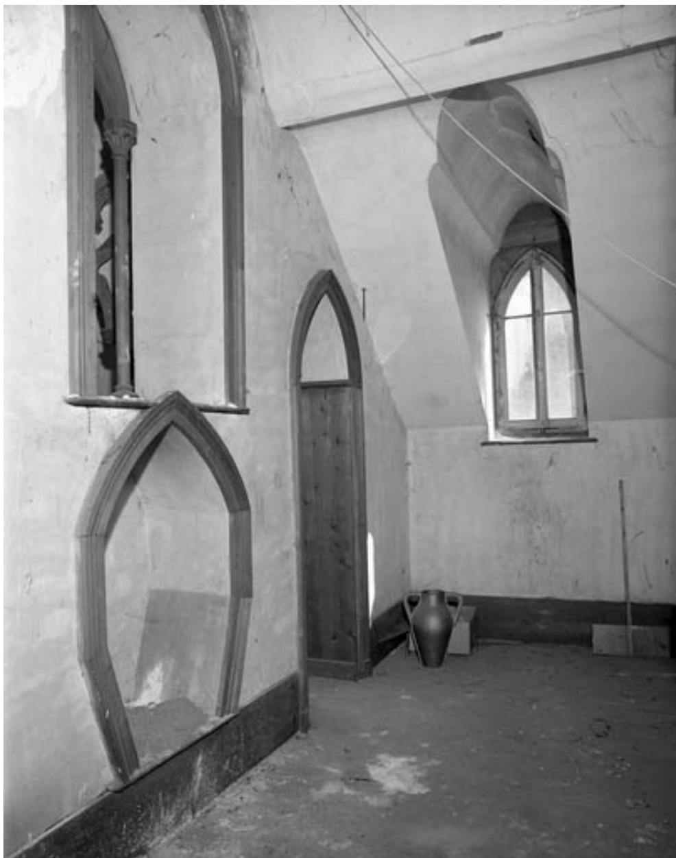
Vue du réduit situé derrière le chœur.
