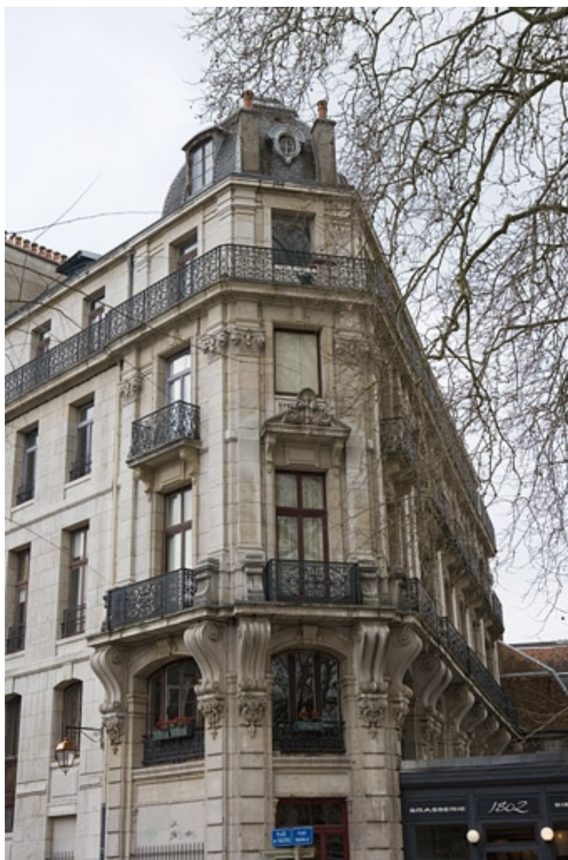
Vue d'ensemble de l'angle de l'immeuble.
