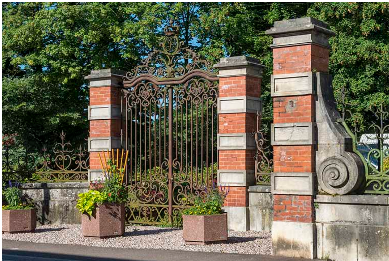
Clôture (grille) sur la rue Armand Paulmard.
