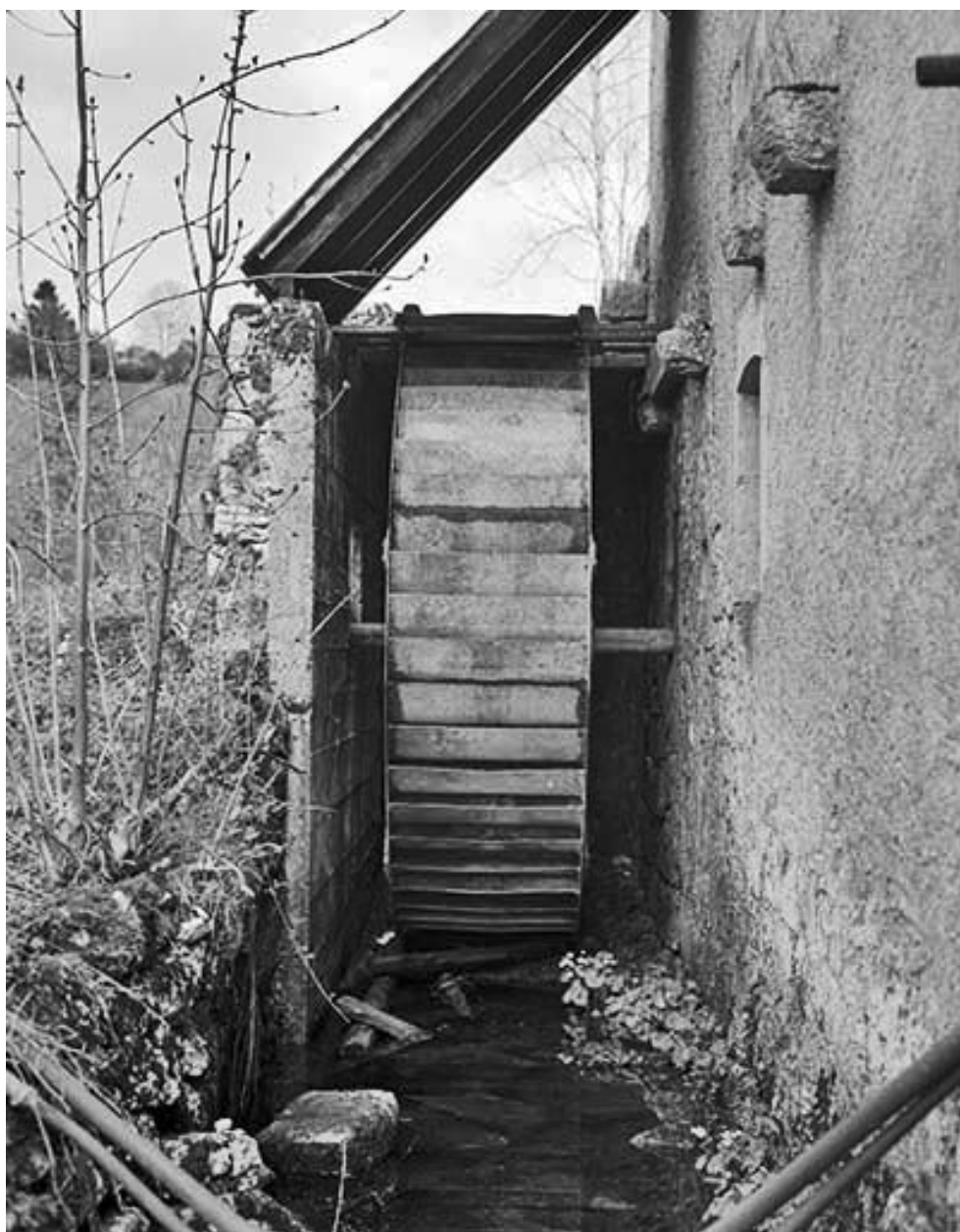
Roue à aubes ou à " augets ".
