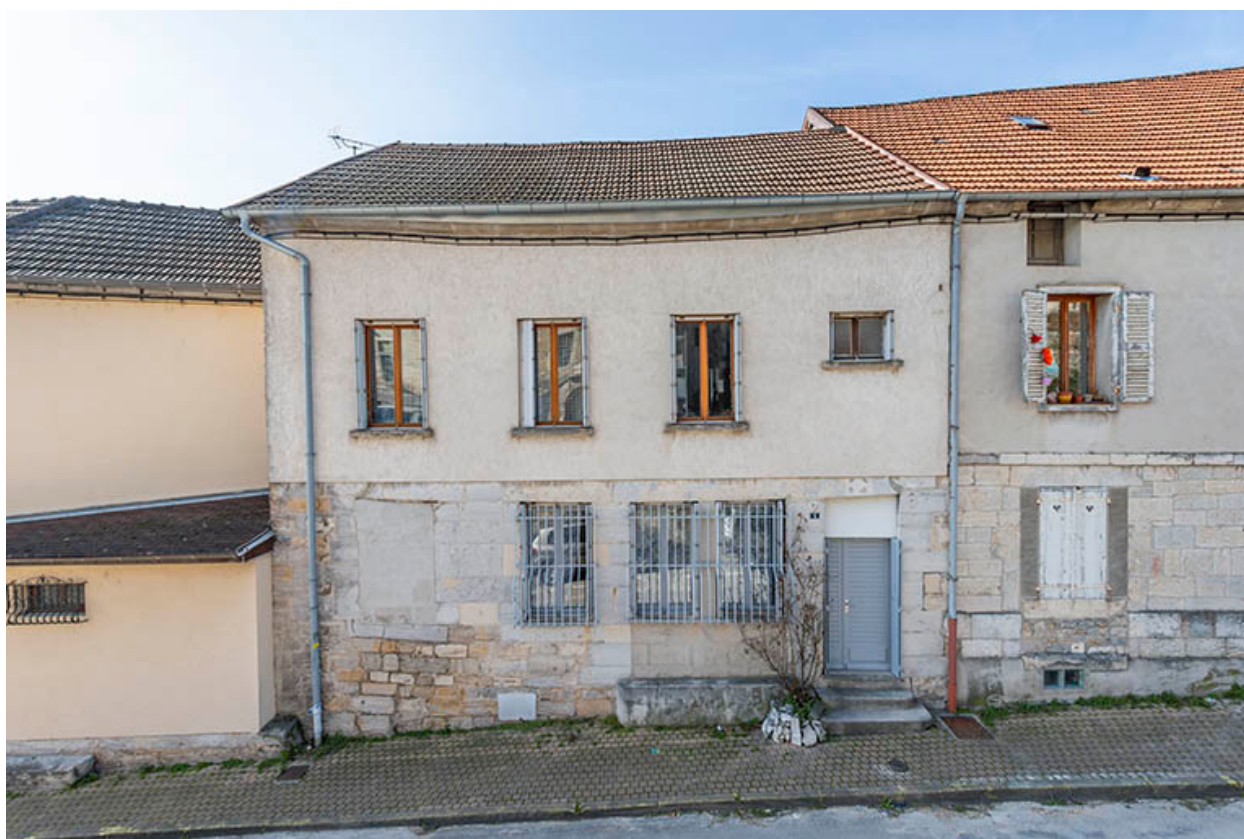
Façade est (rue Charles David).
