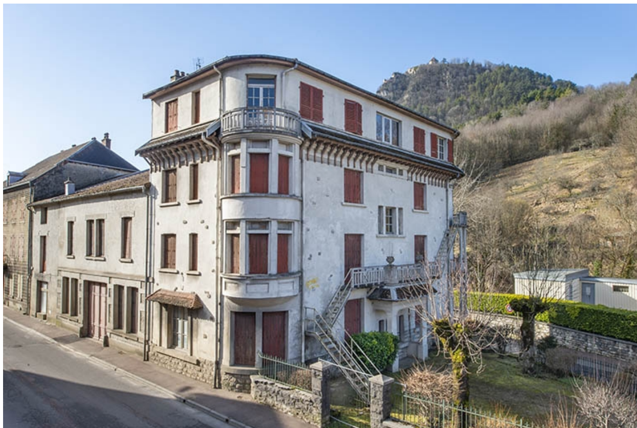
Vue depuis le nord-est.
