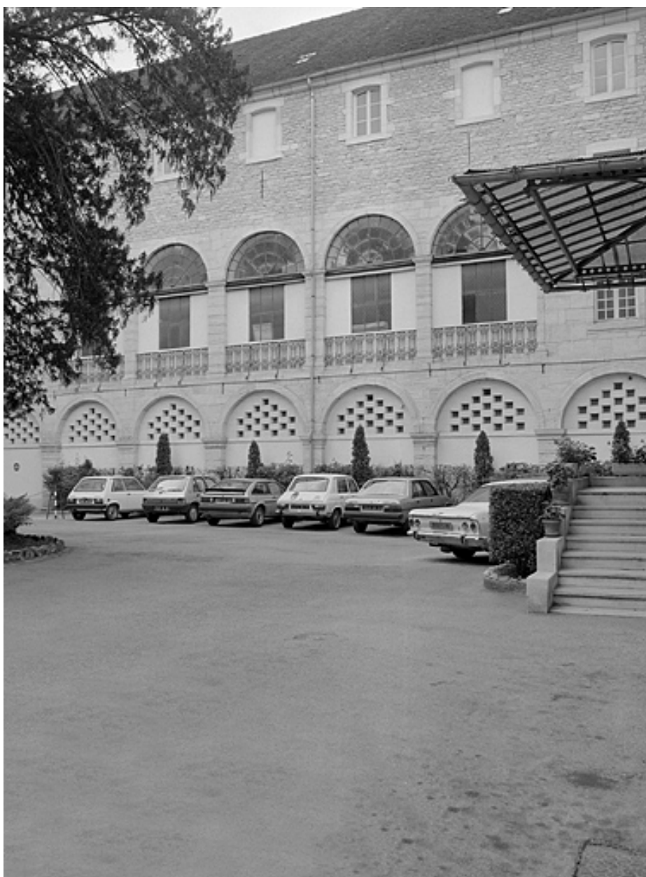
Bâtiments conventuels, cour intérieure, façade nord.
