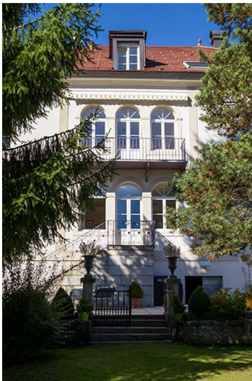
Façade postérieure : travée centrale.
