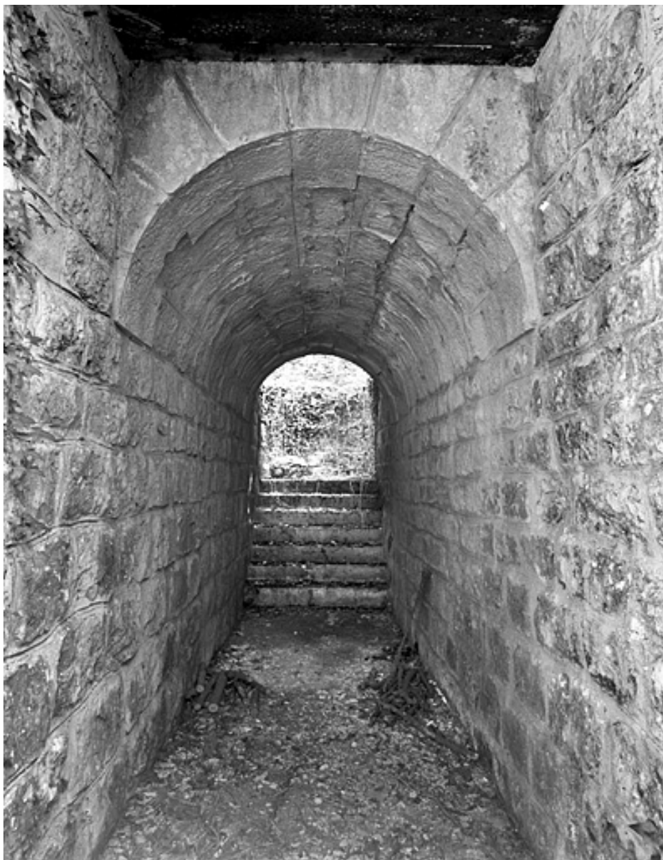
Passage et voûte, depuis l'ouest.
