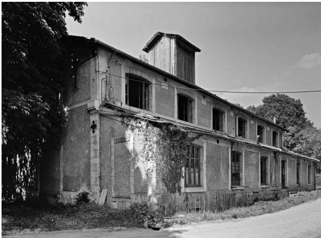
État en 1984, vue depuis le sud-ouest.
