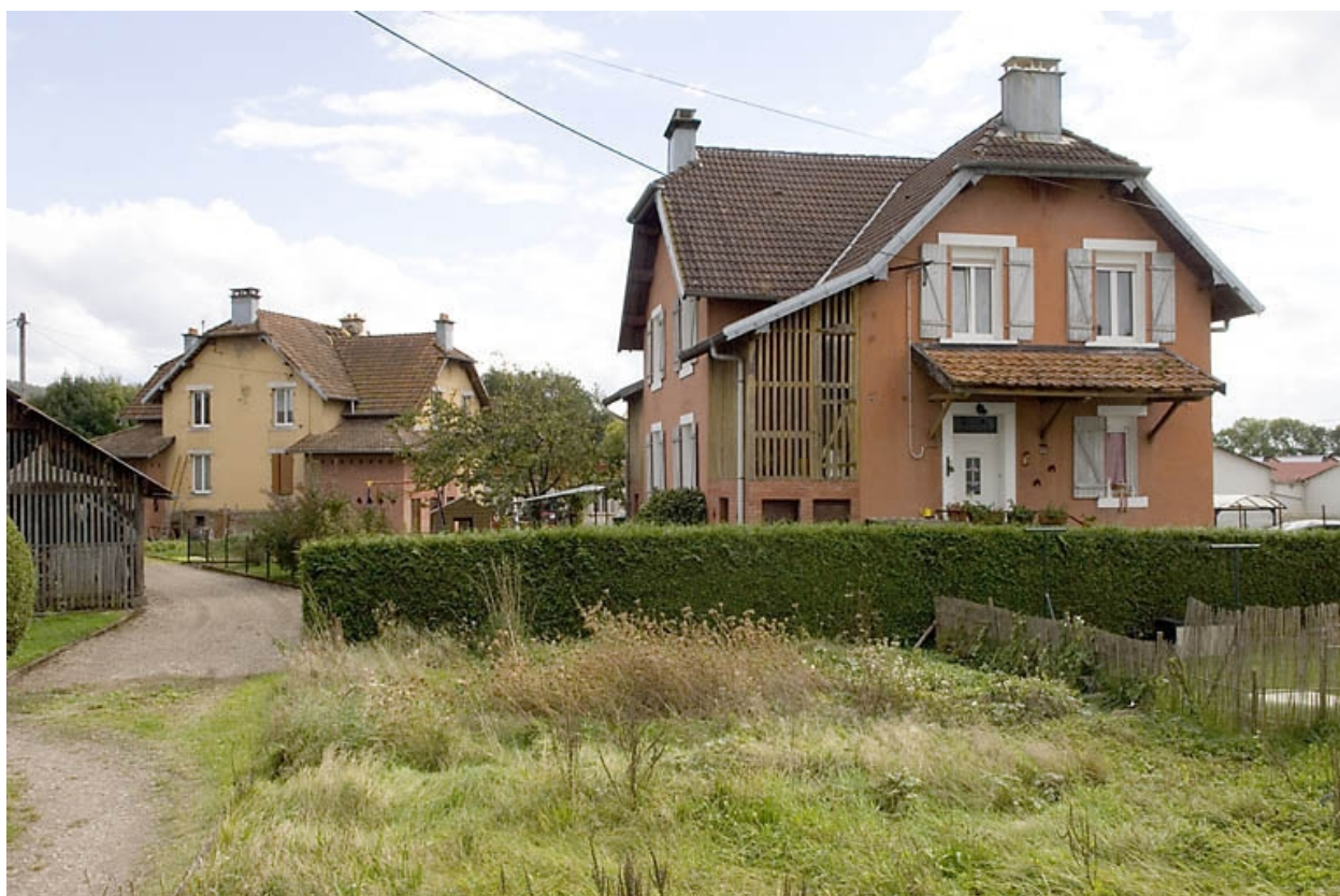
Maisons ouvrières à quatre logements.
