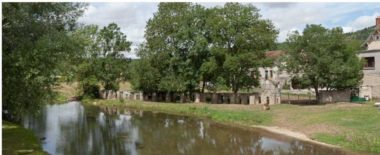
Vue du mur dit "évacuateur de crue".
