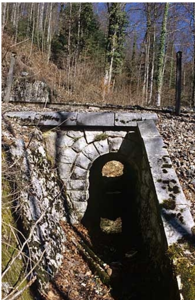
Vue d'ensemble, depuis l'aval (sud).
