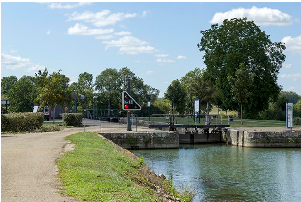
Entrée amont de l'écluse.
