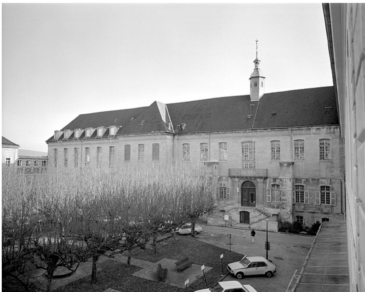
Façade postérieure, vue partielle.
