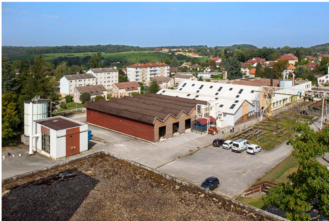
Chantier de grumes.
