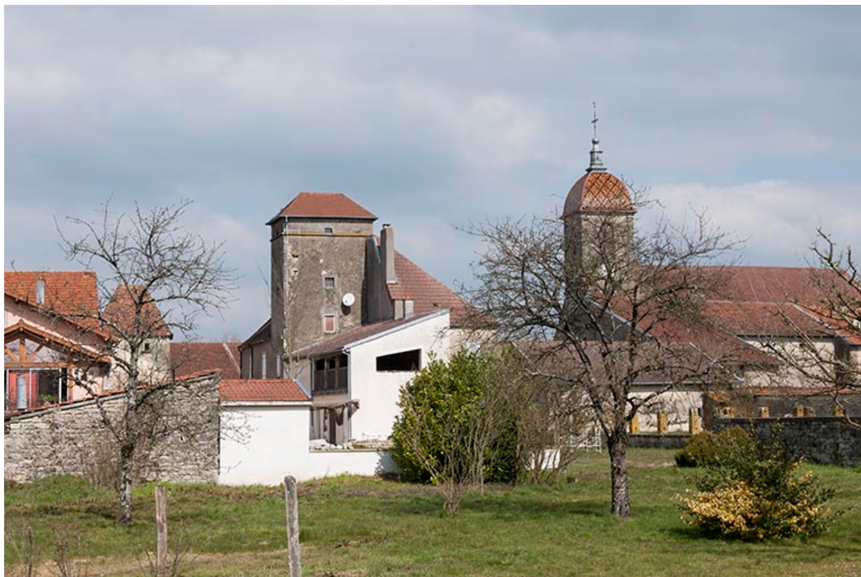
Vue depuis le sud.
