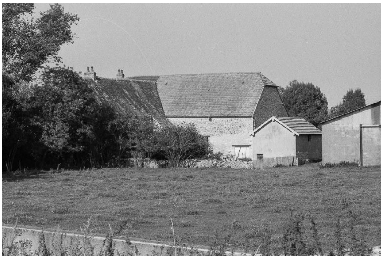
Façade sur cour.
