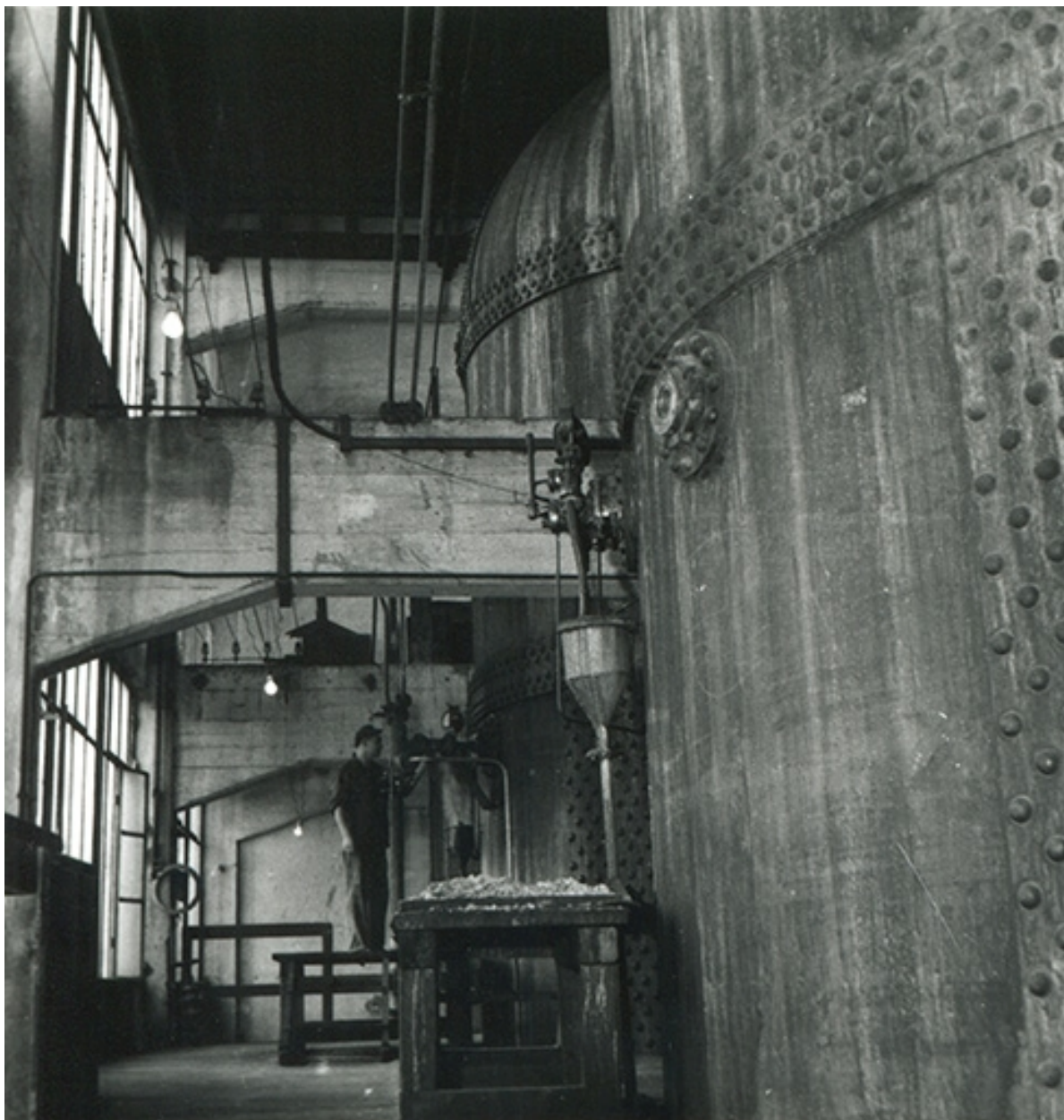
Chaudières (?), fotogr., s.d. [3e quart 20e siècle].
