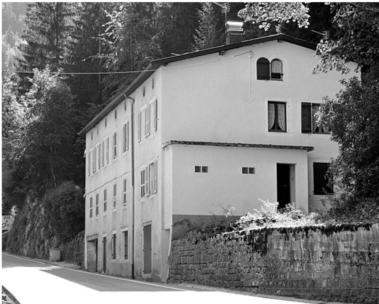
Façades antérieure et latérale droite.
