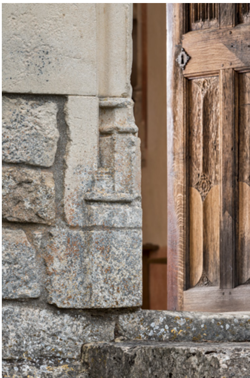
Piédroit, détail de la partie inférieure, gauche.
