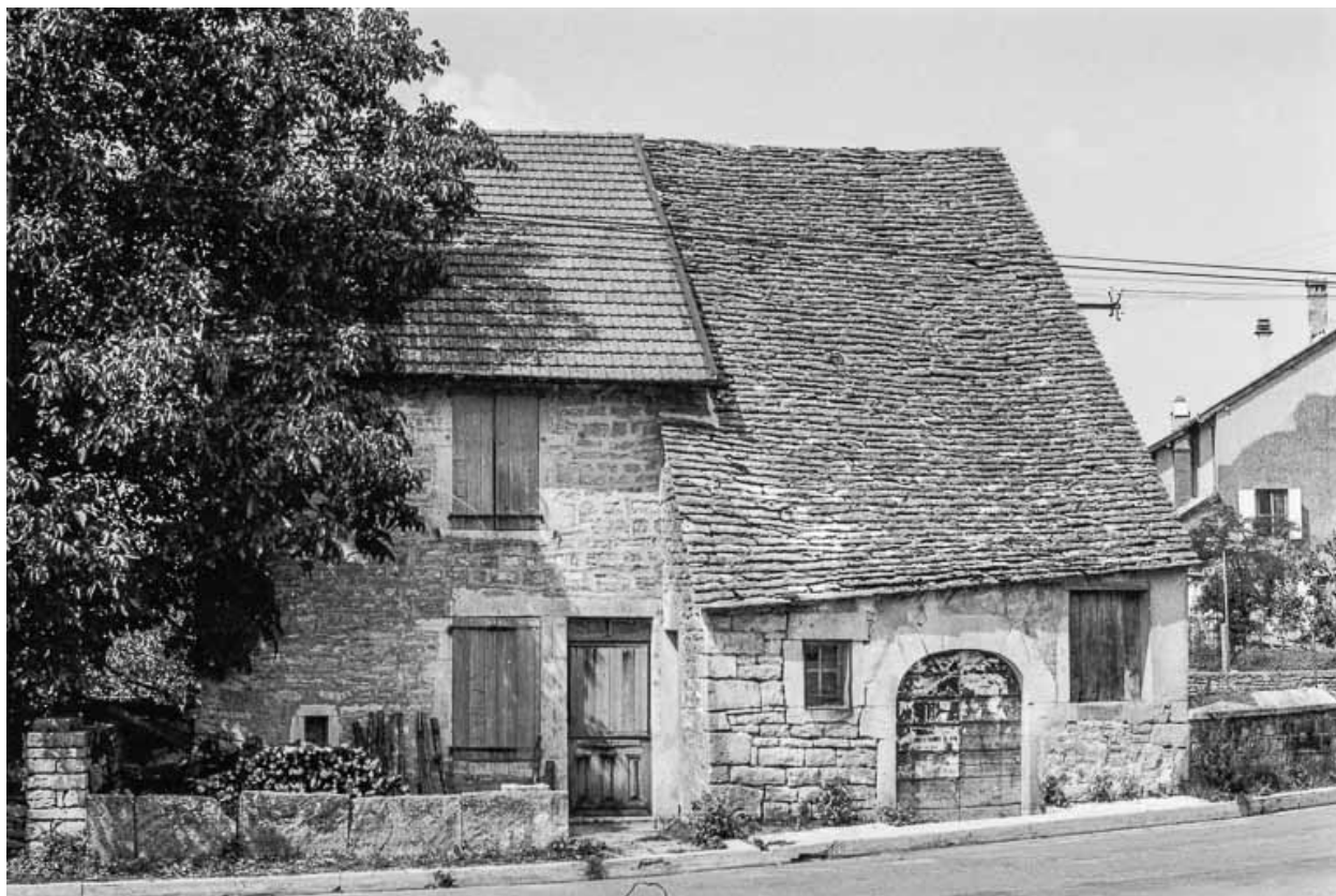
Ferme cadastrée 1951 E1 65 : façade antérieure.
