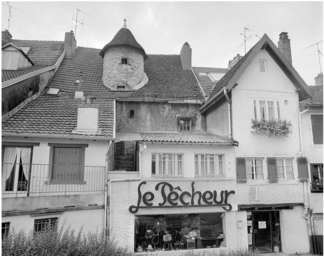
Façade sur la place de la Lizaine.
