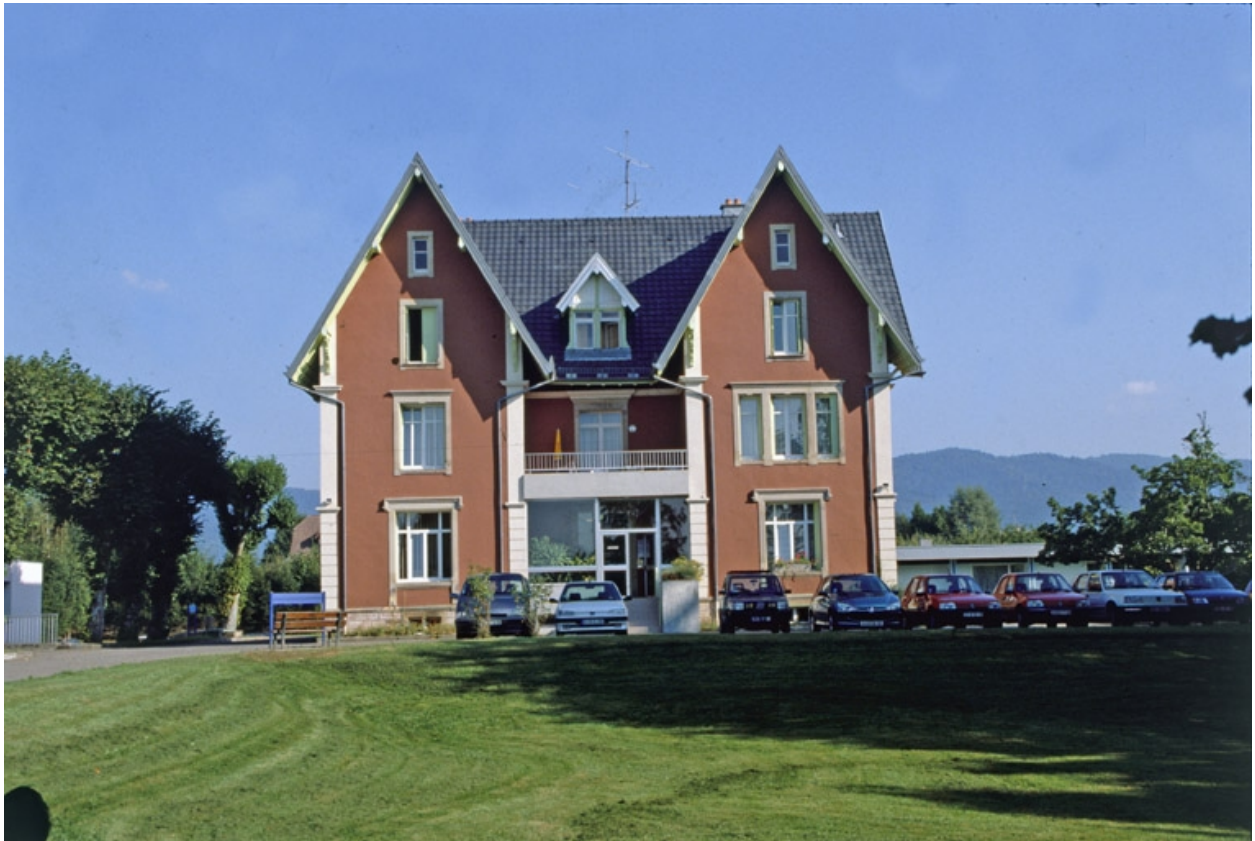
Façade sud-est du logement patronal.
