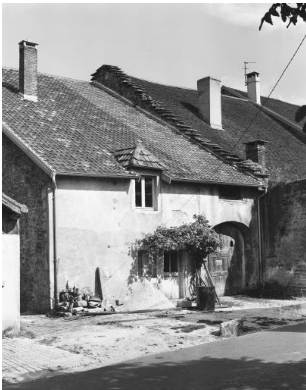
Ferme située à Perrigny.
