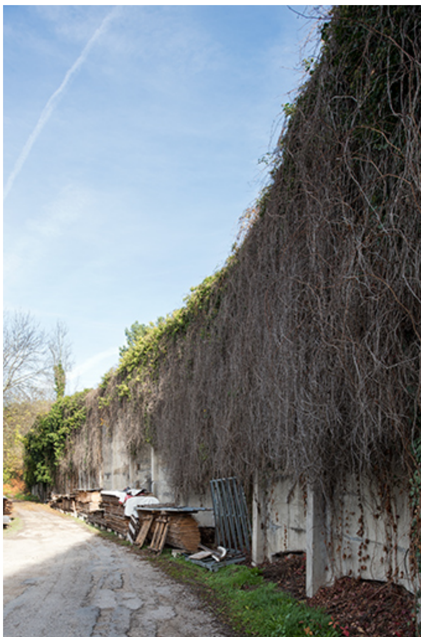
Mur de soutènement, depuis le sud.
