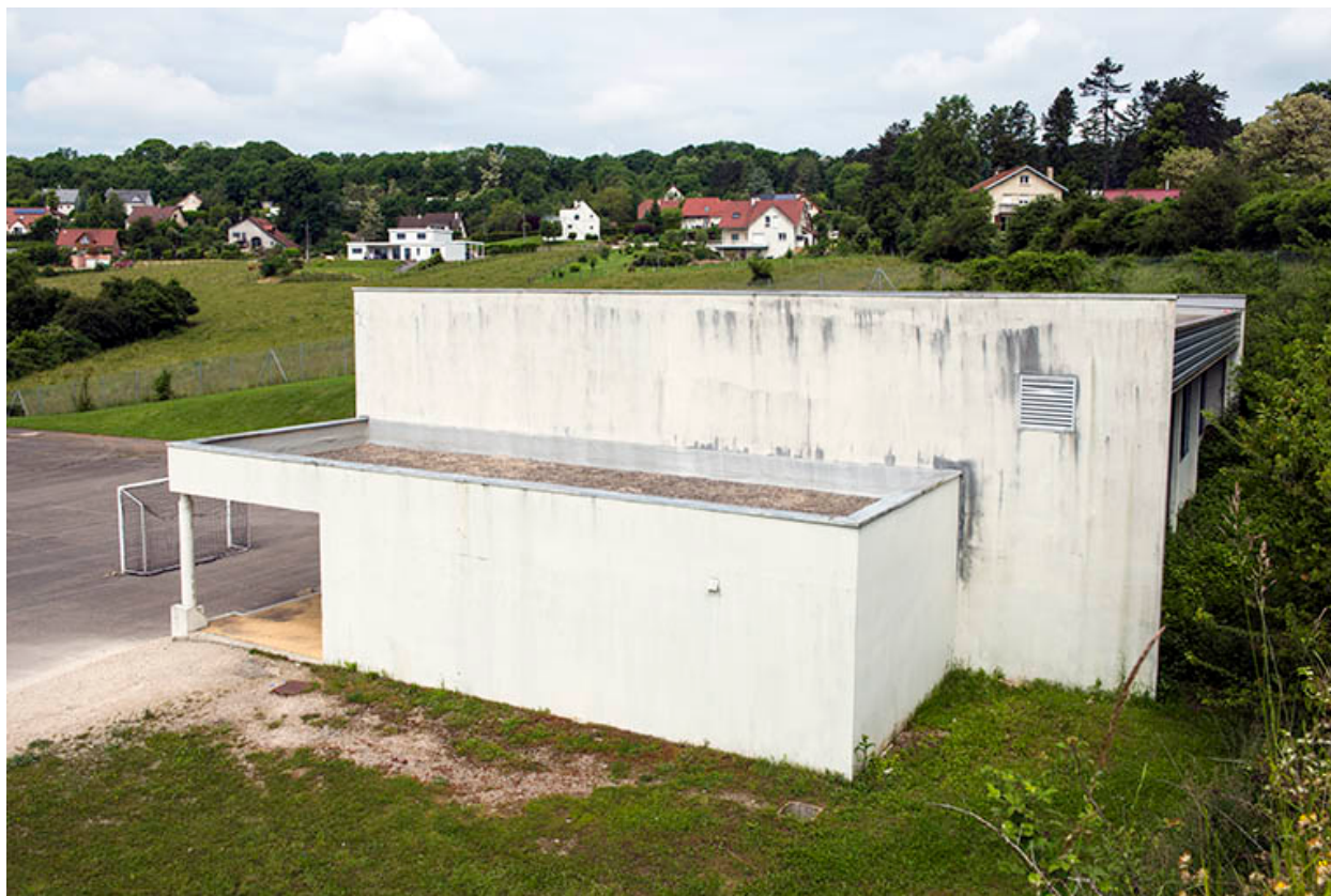
Angle sud-est du gymnase.
